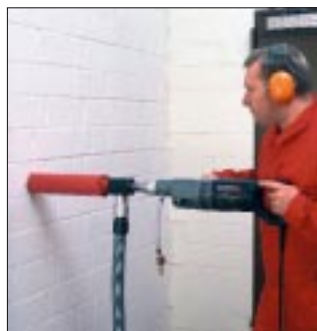
Сверление навесу без подачи воды с использованием отсасывающего ротора и пылесоса
